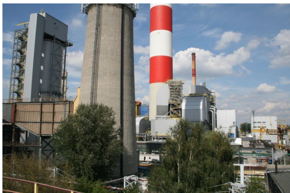
EC Siekierki. Instalacja odsiarczania spalin
