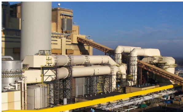
El. Bełchatów. Instalacja odsiarczania spalin
