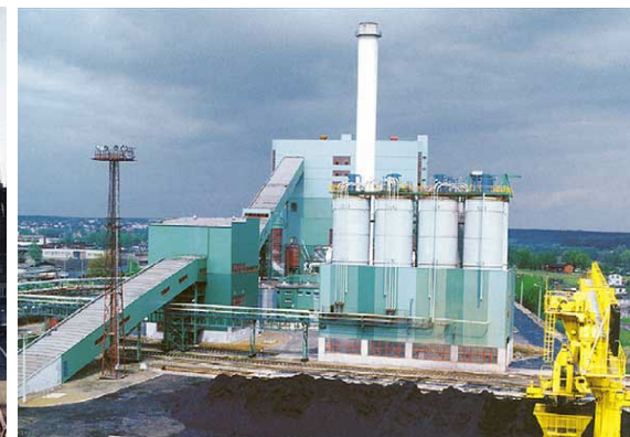
Zakłady Farmaceutyczne Polpharma. Kotle fluidalne
