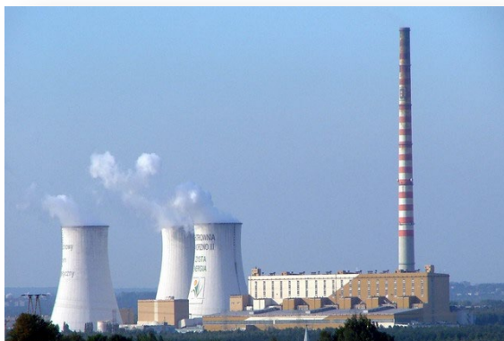
Elektrownia w Jaworznie
