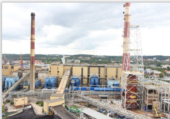
EC Gdańsk. Instalacja odsiarczania spalin (wartość kontraktu 186 mln zł/do realizacji 102,3 mln zł)
