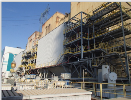
Elektrownia Połaniec. (wartość kontraktu 213,2 mln zł/do realizacji 132,2 mln zł)
