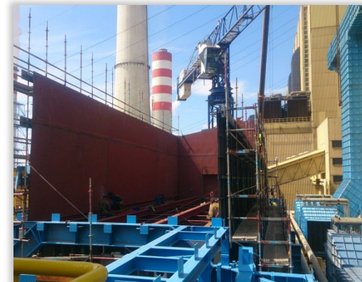
Elektrownia Kozienice. Instalacja Katalitycznego Odazotowania Spalin (wartość kontraktu 191,5 mln zł/do realizacji 143 mln zł)
