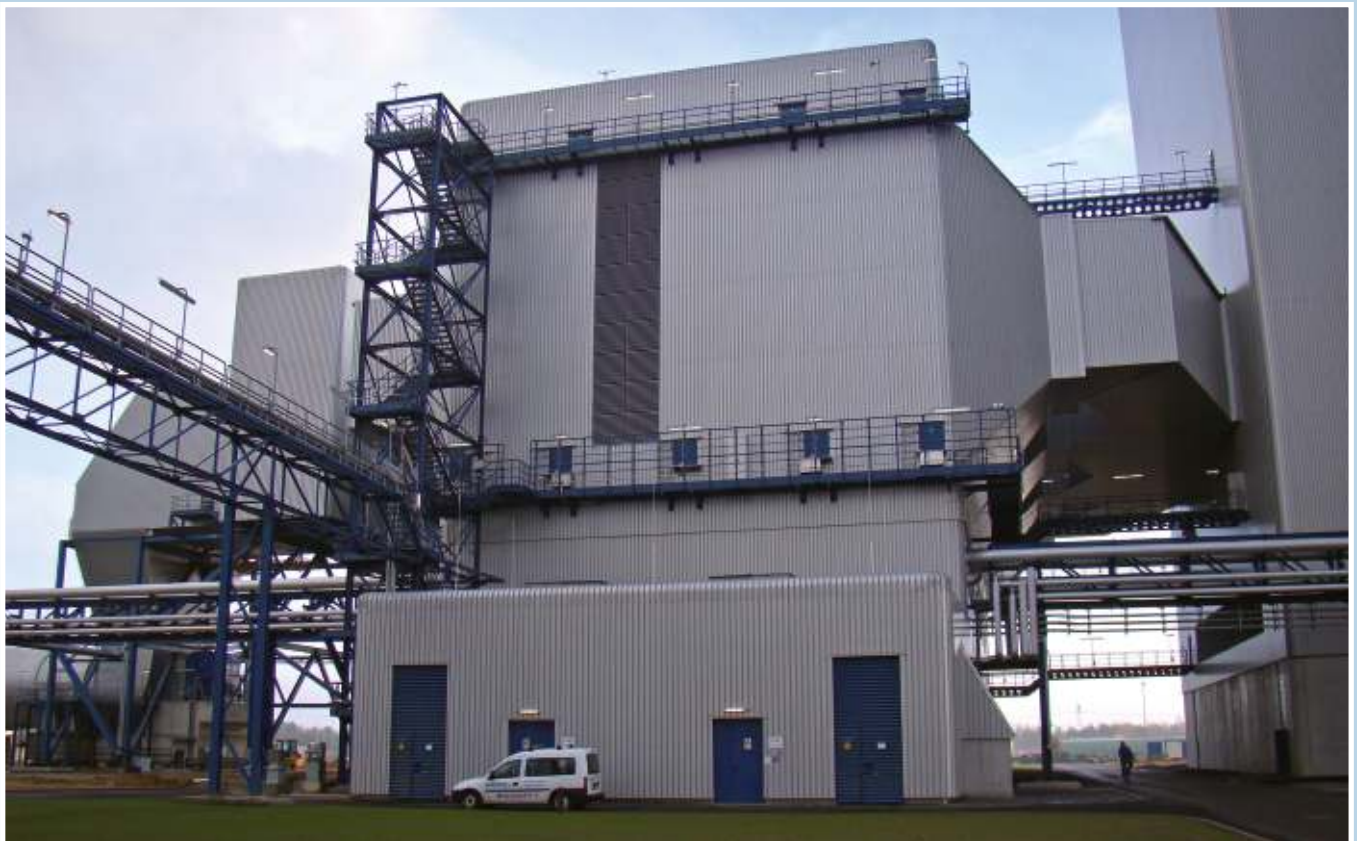
El. Boxberg - Niemcy. Kocioł R – 670 MW – wykonanie, dostawa, montaż i w rozruch
