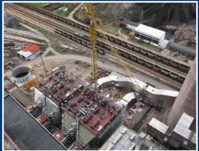
Montaż elektrofiltrów bloku A6 – Obrenovac Serbia
