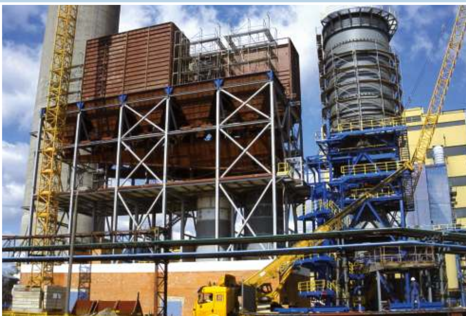
EC Łódź 4. Montaż filtra workowego dla instalacji odsiarczania spalin metodą półsuchą
