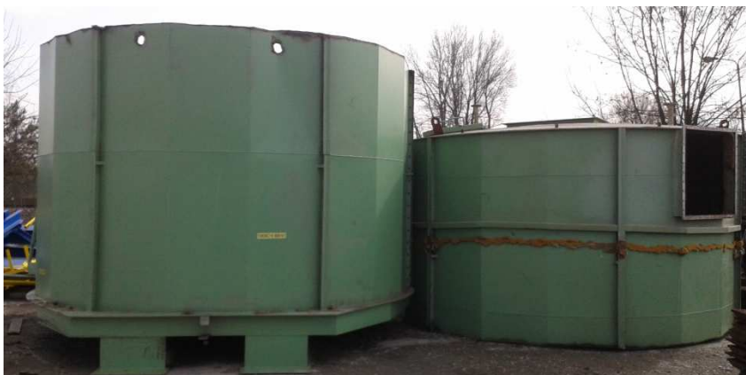
Zbiornik po demontażu: część dolna i górna
